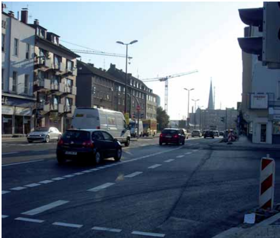
Jetzt fließt der Verkehr in Richtung City über die Rheinische Straße. Foto: Tiefbauamt Stadt Dortmund
