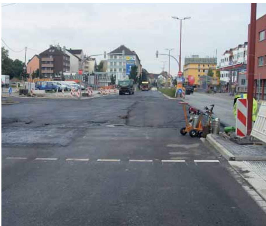
Die Fahrbahn in Richtung Innenstadt kurz vor ihrer Vervollständigung.
