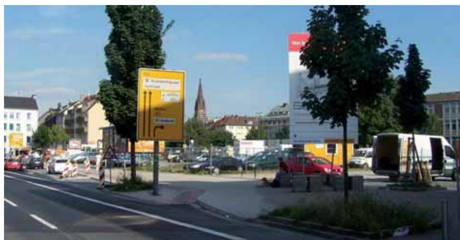
Die momentane Situation: Eine Baulücke zwischen Rheinische und Lange Straße Foto: Jochen Nähle
