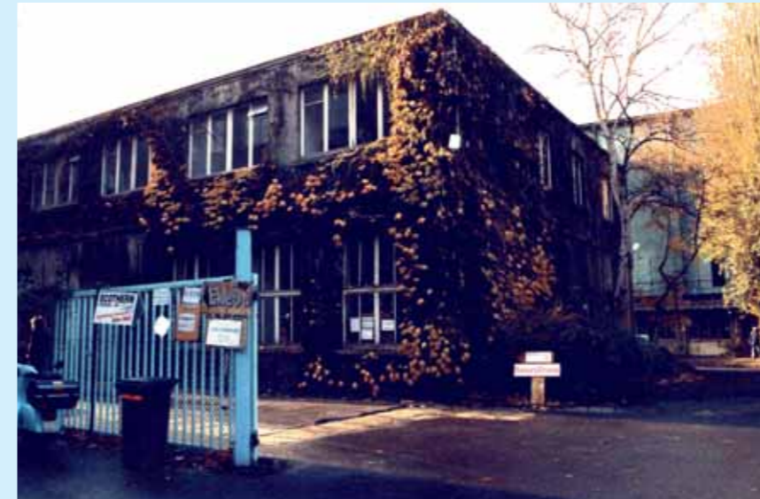
Vor und nach der Aufstockung: das Magazin-Gebäude
