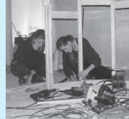
Im Projekt Handfest wurde 1996 u.a. die Gemeinschaftsküche gebaut – hier die Holzständerkonstruktion für einen runden Raumteiler mit Lehmausfachung Foto: Handfest-Archiv
