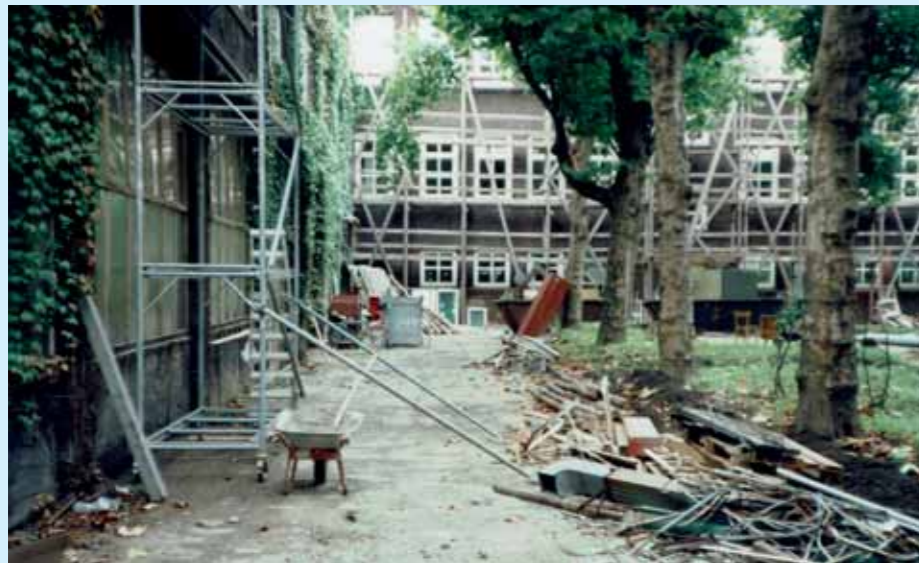
Anfang der 1990er wurden die neuen Holzfenster eingesetzt. Foto: Martin Hiddemann
