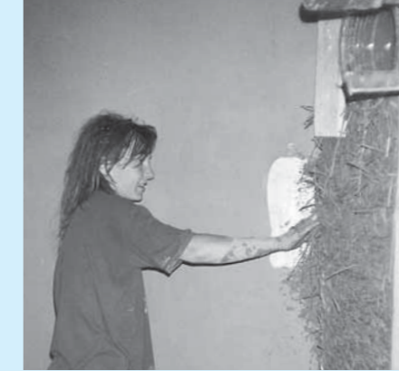
Im Projekt Handfest wurde 1996 u.a. die Gemeinschaftsküche gebaut – hier die Holzständerkonstruktion für einen runden Raumteiler mit Lehmausfachung Foto: Handfest-Archiv
