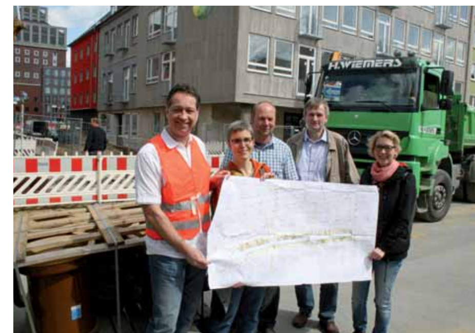
Bis mindestens Jahresende bleibt die Lange Straße eine Baustelle (Fotos oben), doch Michael Quandt, Dorit Gloth, Dietmar Anhalt, Ulrich Stein und Ina Bahr wissen, wie die Straße dann später aussehen wird. Fotos: Gesine Lübbers
